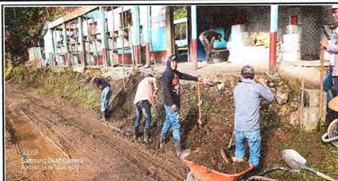
Foto 1: Mejoramiento del muro perimetral
