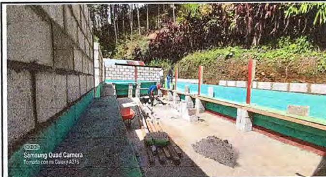
Foto 2: Mejoramiento de paredes.
