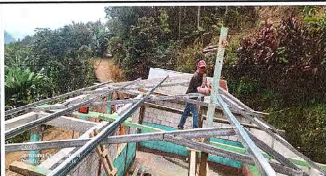
Foto 3: Sustituyendo el entechado.
