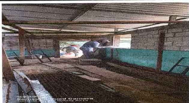
Foto 5: Colocación de nuevas ventanas.
