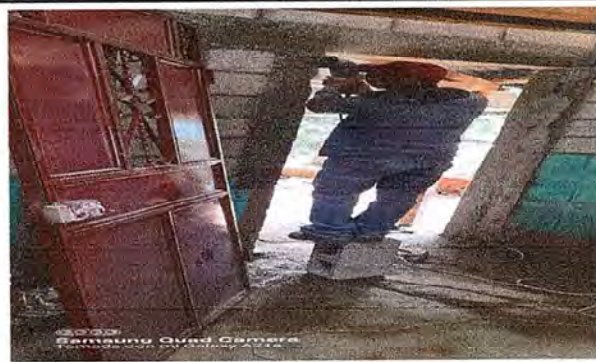
Foto 4: Colocacion de nuevas puertas.
